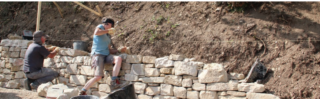
Trockenmauer im Aufbau
