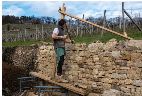
Sanierung an der Stützmauer Alte Gasse Schinznach Foto: Jurapark Aargau
